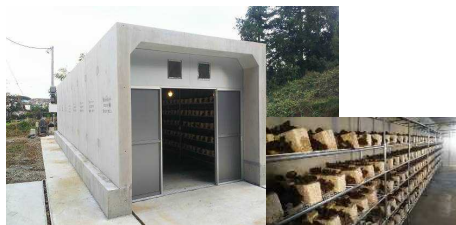
ボックスカルバート施設と内部
