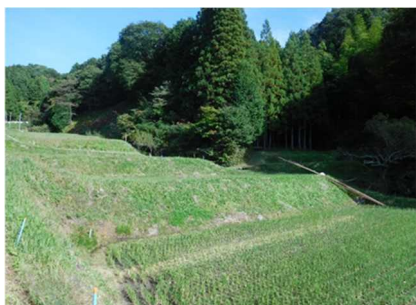
適正に管理されている急傾斜法面
