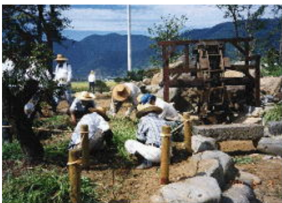
【ふくざわ公園造成の様子】
