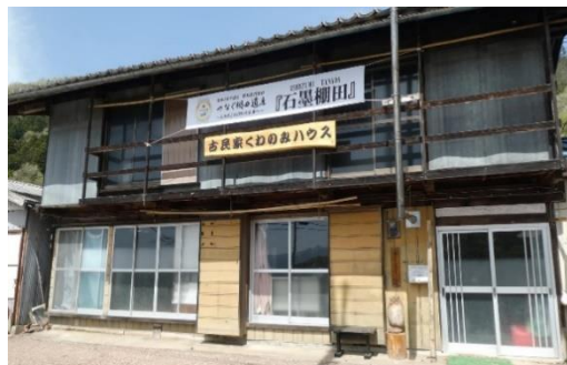
写真3 活動拠点「くわのみハウス」
