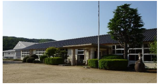
写真 1 朝日里山学校外観
