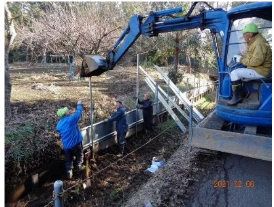
写真 5 水路の補修の様子
