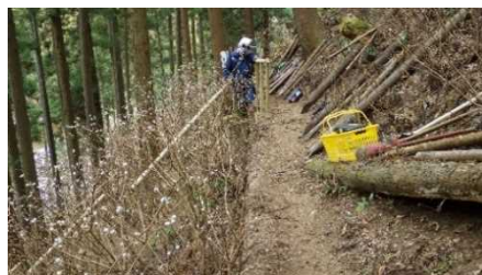
ミツマタ群生地遊歩道整備
