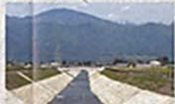
あづみ野排水路
