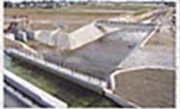
拾ヶ堰・あづみ野排水路合流工
