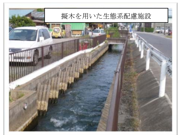
【写真 生態系に配慮した施設（加須市(旧大利根町)）】
