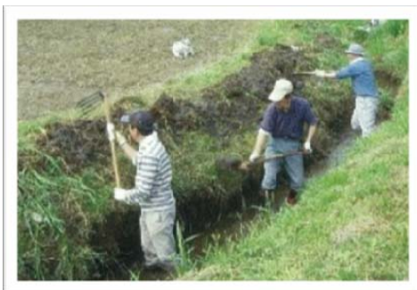
【写真 生き物に配慮した水路整備の様子】
