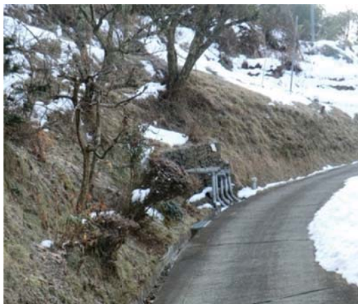
水抜きボーリング、排水路（中原区域）
