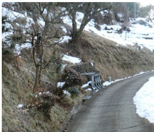
水抜きボーリング、排水路（中原区域）
