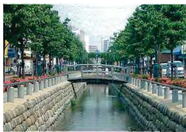
【荒川左岸幹線用水路】
