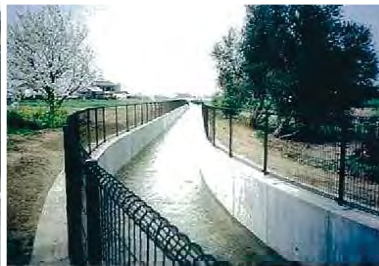
【奈良堰幹線用水路】
