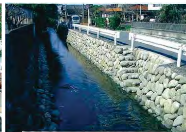
【御正吉見堰幹線用水路】
