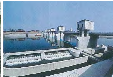
【流水改善水路】
