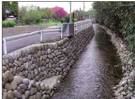
【御正吉見堰幹線用水路の親水護岸】
