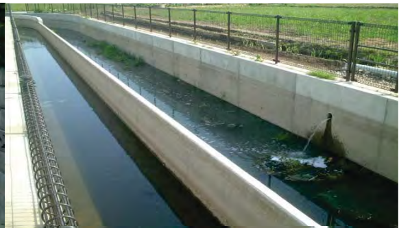
【背割りによる用排分離状況(奈良堰)】
