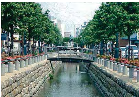
【荒川左岸幹線用水路】
