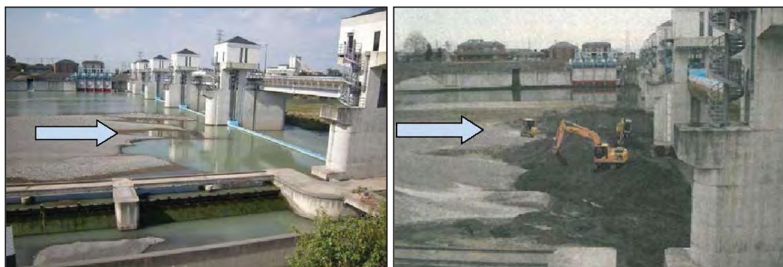
【六堰頭首工での堆積土砂除去状況】
