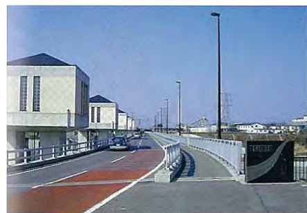
【農道橋(重忠橋)】
