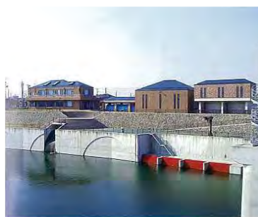
【管理棟・取水口】
