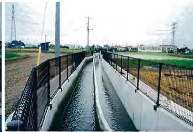
【玉井堰幹線用水路(柿沼堀)】
