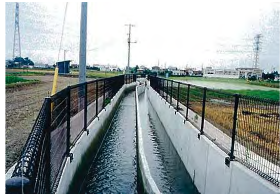
【玉井堰幹線用水路(柿沼堀)】
