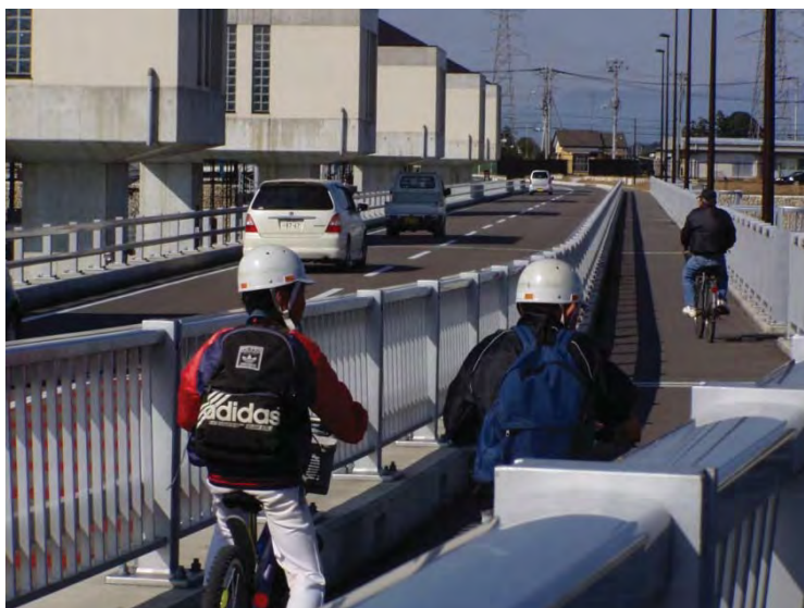
【六堰頭首工の管理橋】
