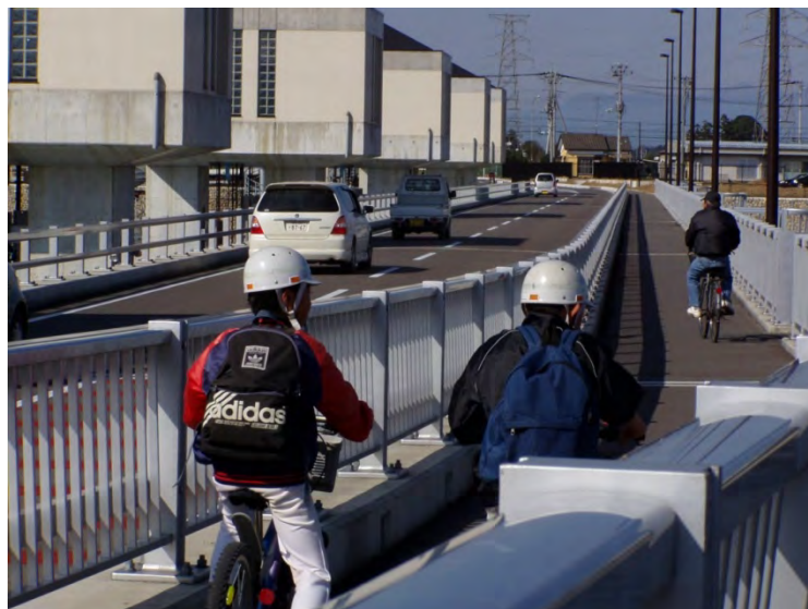
【六堰頭首工の管理橋】
