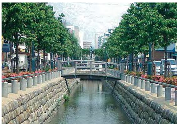
【荒川左岸幹線用水路】
