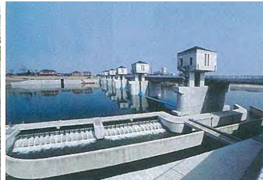
【流水改善水路】
