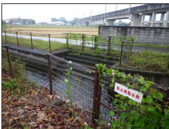
【水路に設置された防火用取水柵】
