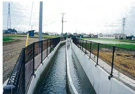
【玉井堰幹線用水路(柿沼堀)】
