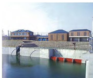
【管理棟・取水口】
