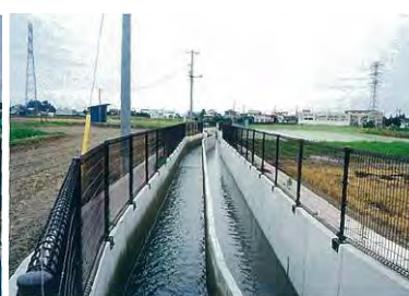
【玉井堰幹線用水路(柿沼堀)】
