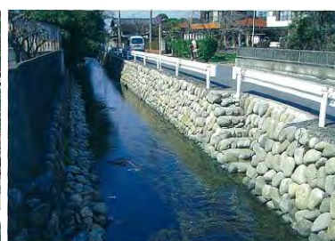
【御正吉見堰幹線用水路】
