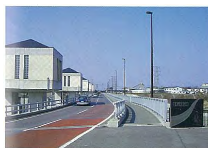
【農道橋(重忠橋)】
