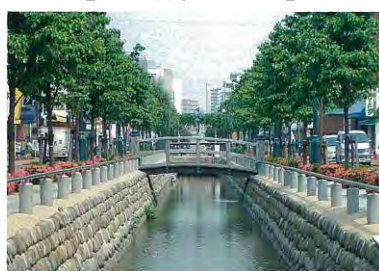
【荒川左岸幹線用水路】
