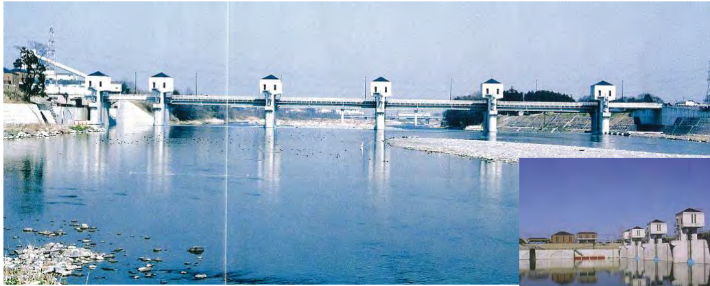
【本事業で改修した六堰頭首工】
