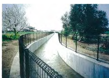
【奈良堰幹線用水路】
