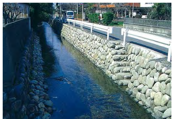
【御正吉見堰幹線用水路】
