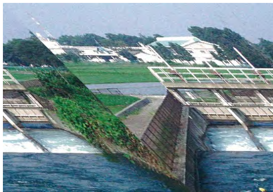
【大里幹線分水工(明戸斜流分水工)】
