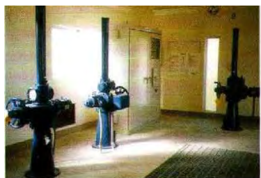
取水堰ゲート操作室
