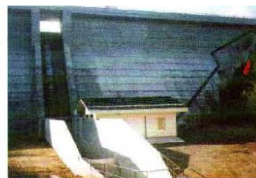
放流ゲート操作室
