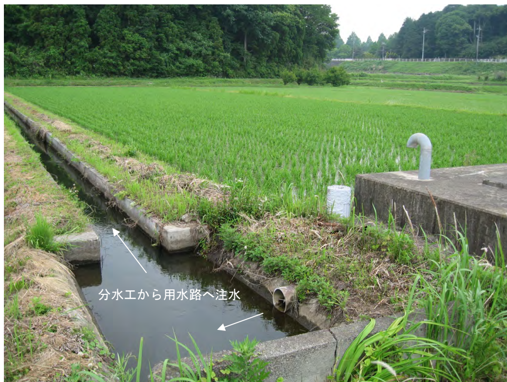
【大川幹線分水工（農業用用水路へ用水を注水している箇所）】
