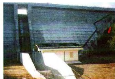
放流ゲート操作室
