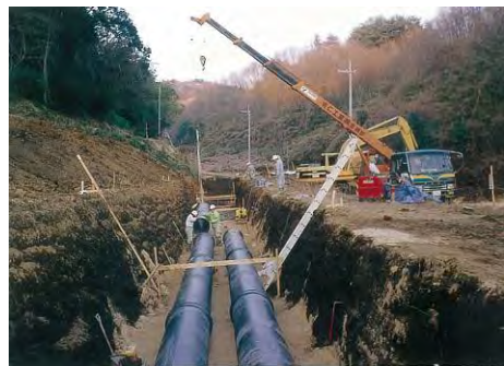
左側：小宅送水路、右側：小宅幹線用水路
