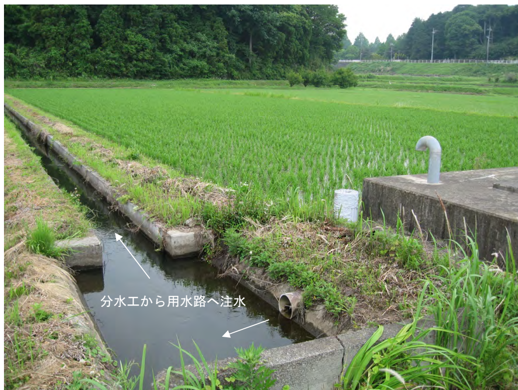
【大川幹線分土工（農業用用水路へ用水を注水している箇所）】
