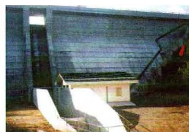
放流ゲート操作室
