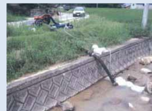
仮設ポンプを設置し、用水を確保
