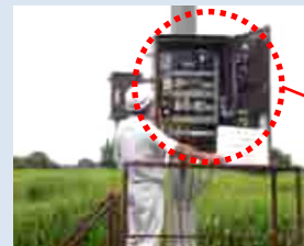
浸水した揚水機場の制御盤の部品を交換することにより ポンプ機能を回復
