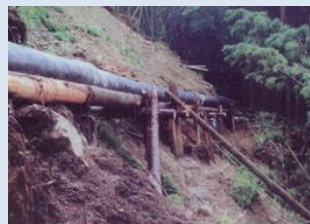
仮設水路を設置し、用水を確保
