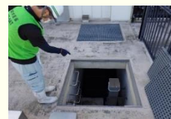
農業集落排水施設の点検
