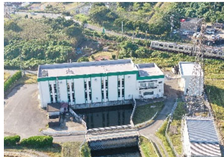
揚水機場（改修後）
