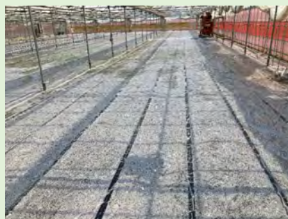
かん水チューブによる低濃度エタノール処理の様子
