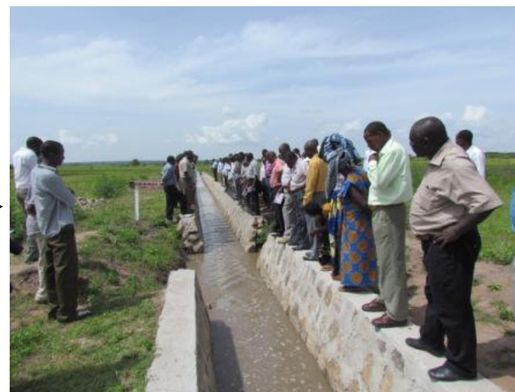
⑧完了、通水
