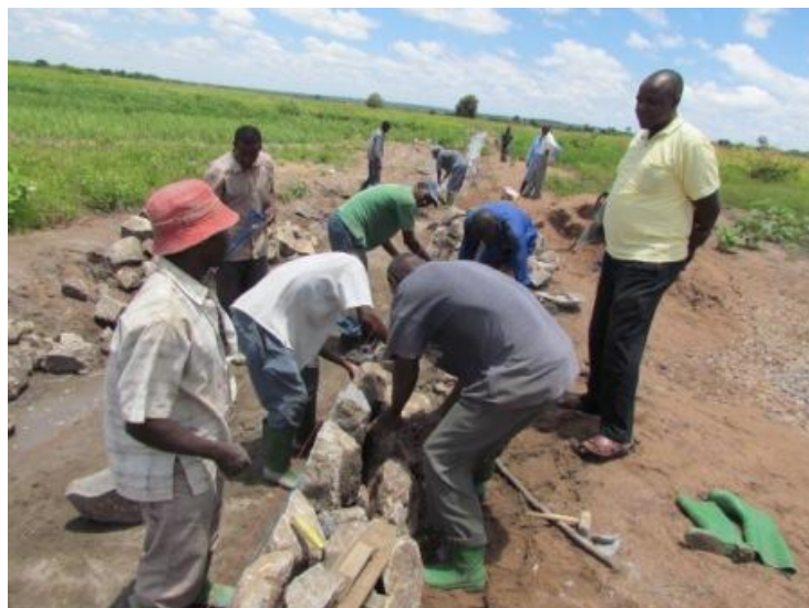
⑦みんなで施工
