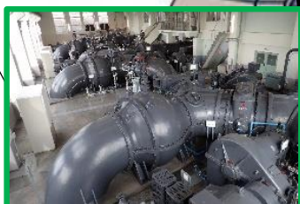
手賀排水機場 (千葉県柏市)
