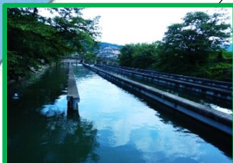
幹線用水路 (埼玉県神川町)
