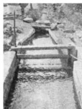
大洞水道取入口
