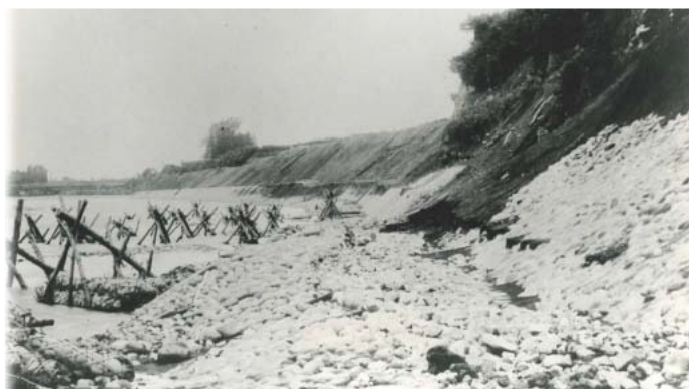
古くから天狗岩取水口付近で使われていた水制工法「越中杵」
