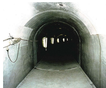
1998年改修当時の隧道 （コンクリート巻立て）
