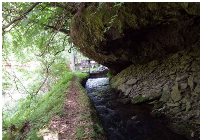
岩をくりぬいた水路（滝之湯堰）
