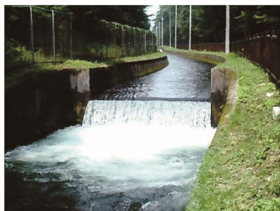
現在の那須疏水幹線水路
