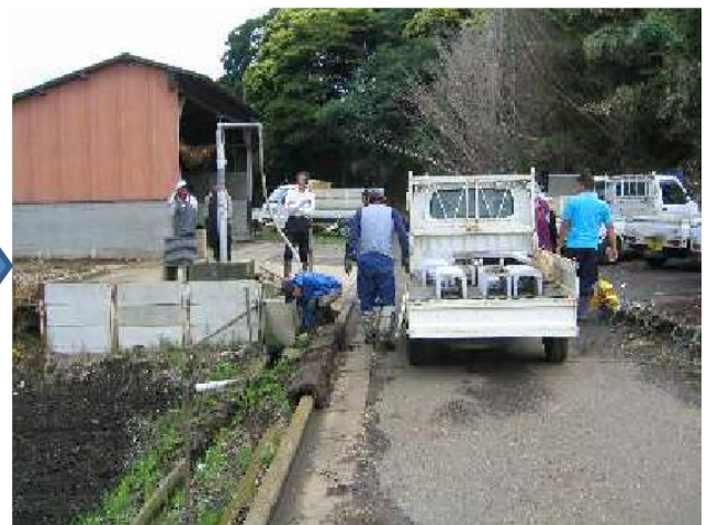
U字溝の補修
