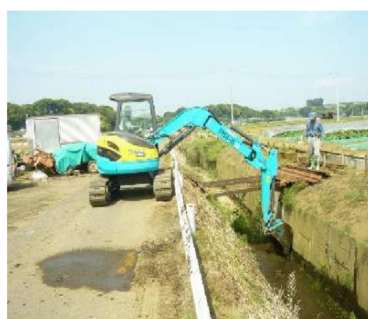
大型機械による泥上げ作業
