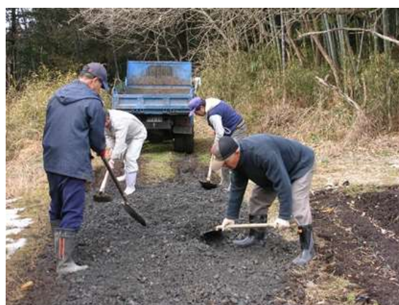
農道補修(砂利敷き)
