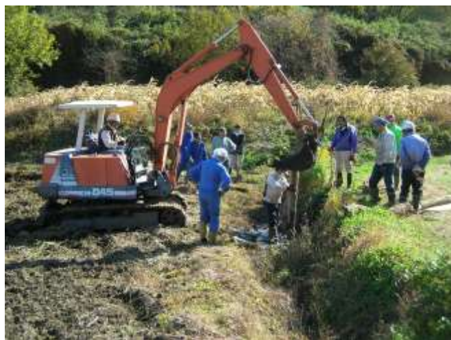
直営による水路補修
