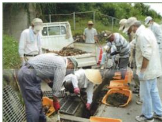
水路の泥上げ作業
