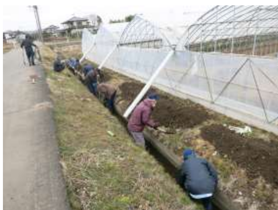
水路の泥上げ作業
