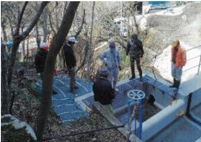
水路点検の様子
