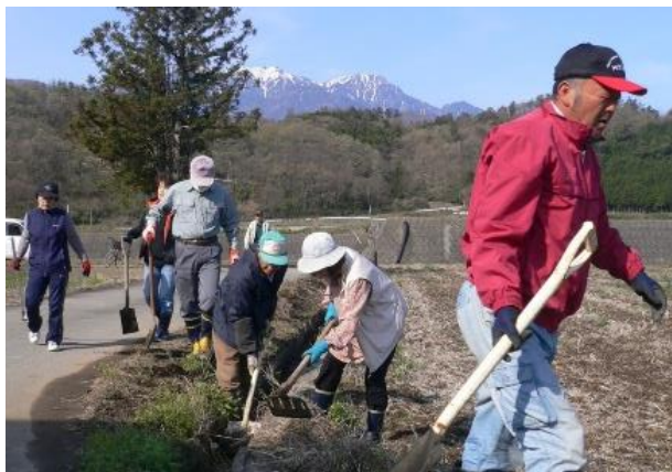
水路の泥上げ作業
