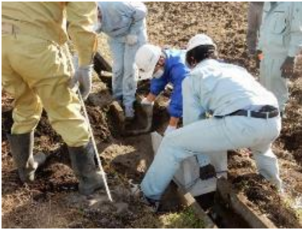
高校生による水路の補修
