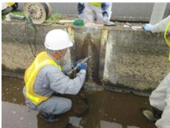
直営による水路補修
