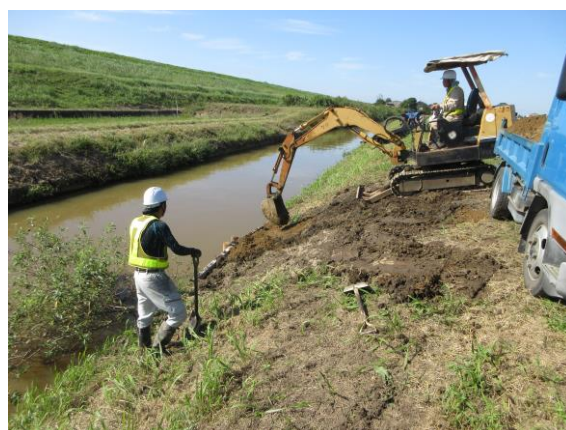
大型機械による泥上げ作業
