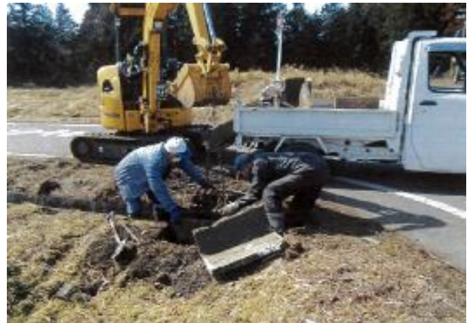
直営による水路補修
