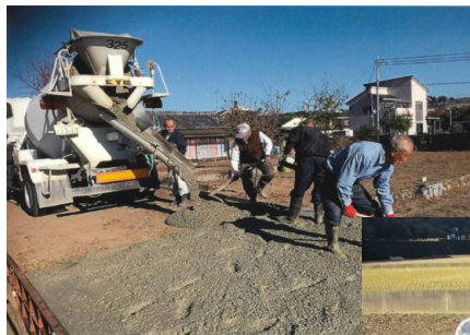
直営による農道舗装
