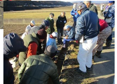
水路補修の実技研修
