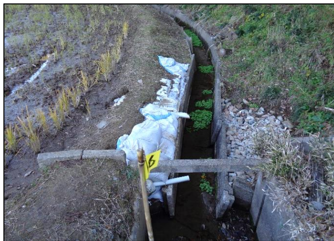
直営で設置した土留め
