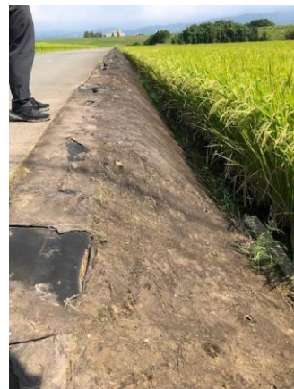
防草シートの設置
