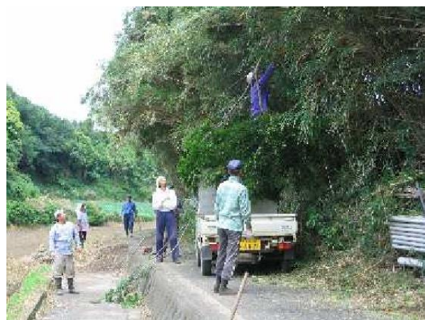
支障木の除去作業
