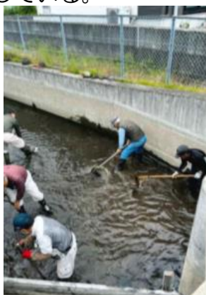
水路の泥上げ作業
