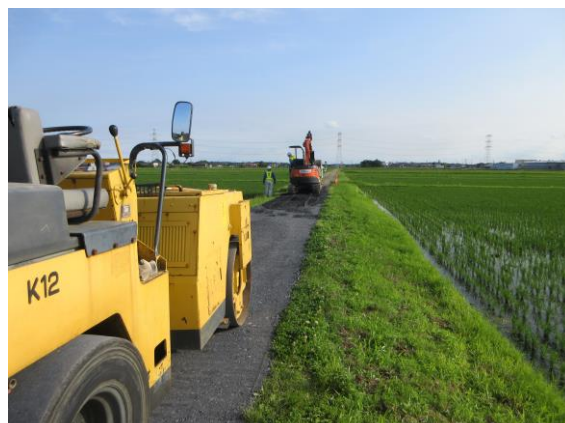
直営による農道舗装
