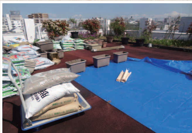
コンクリートの屋上に菜園設営
