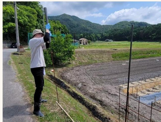
獣害防止柵の設置
