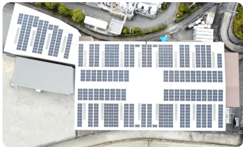
UCC兵庫工場設置太陽光パネル
