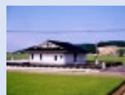
農業集落排水施設
