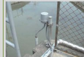
水位計の設置
