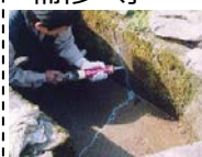
水路のひび割れ補修
