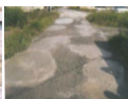
農道の窪みの補修
