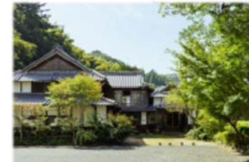
受入拠点の改修
