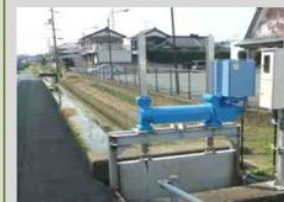
排水門の電動化
