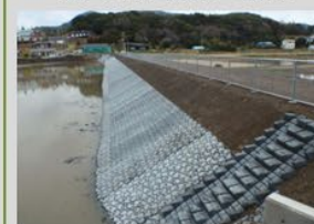
ため池護岸の整備
