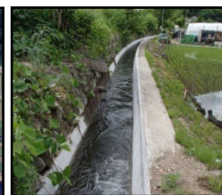
老朽化した用水路の整備・更新
