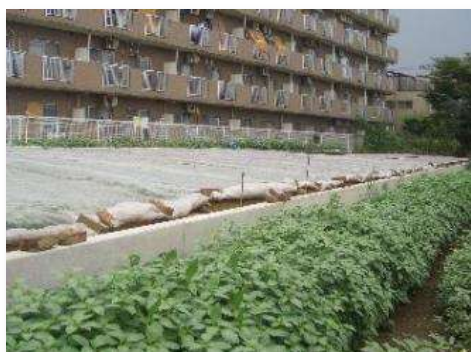
土砂流出対策の土留め
