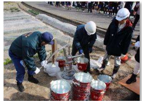
防災兼用井戸の整備
