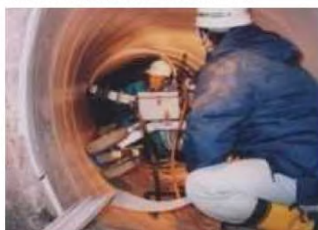
【管水路の調査点検・機能診断】
