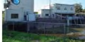
排水機場の監視・制御
