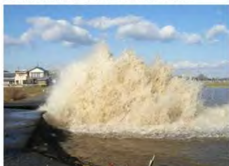
【管水路の突発事故（管の破裂）】
