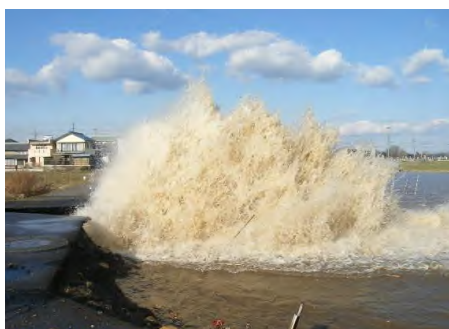
【管水路の突発事故（管の破裂）】
