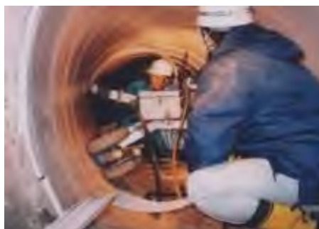
【管水路の調査点検・機能診断】
