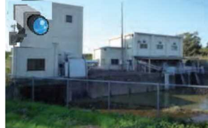
排水機場の監視・制御
