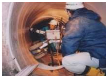
【管水路の調査点検・機能診断】
