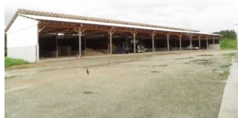
畜産クラスター事業で整備した堆肥舎
