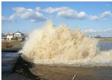
【管水路の突発事故（管の破裂）】
