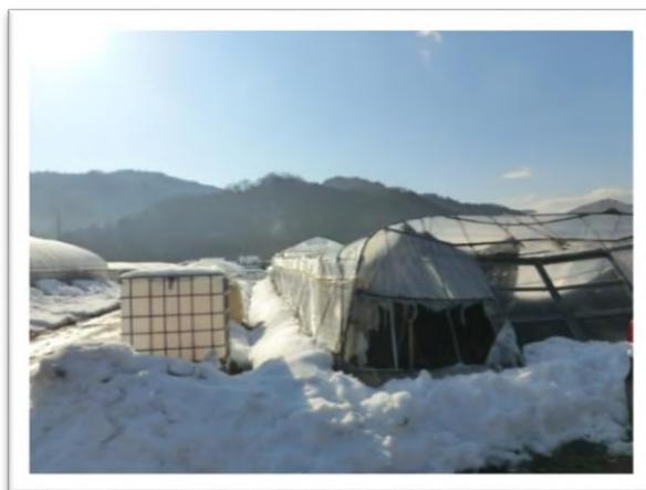
積雪によるビニールハウス倒壊(兵庫県豊岡市)
