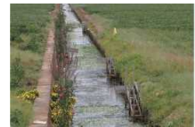
水路に設置された魚道
