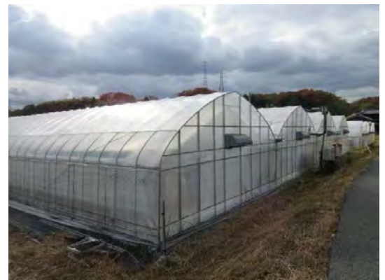
農地を借りてパイプハウスを整備
