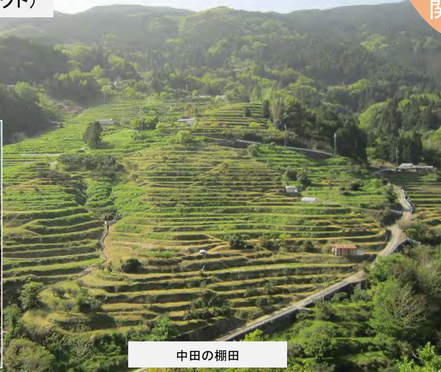
棚田の水資源を支えてきた貴重な土木遺産「竜王水」
