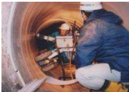
【管水路の調査点検・機能診断】
