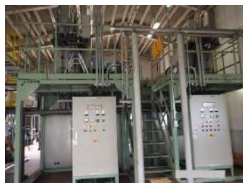
農業集落排水施設の整備
