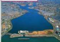
排水機場と周辺の市街地
