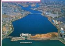
排水機場と周辺の市街地
