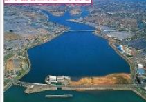
排水機場と周辺の市街地
