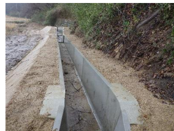
農業生産基盤の整備
