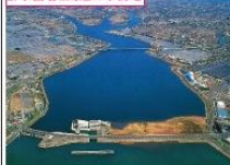
排水機場と周辺の市街地
