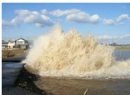
【管水路の突発事故（管の破裂）】
