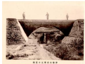
建設当時の煉瓦造りの水路橋
