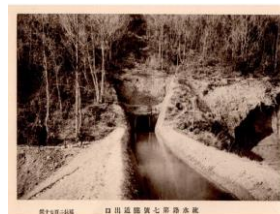
山を貫く水路トンネル
