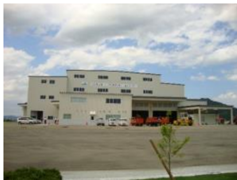
ブランド米に対応した穀類共同乾燥調製貯蔵施設（兵庫県豊岡市）
