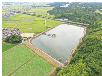
用水施設の整備(調整池)
