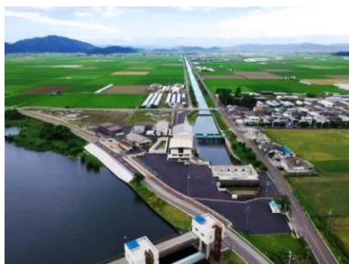
排水施設の整備(排水機場)
