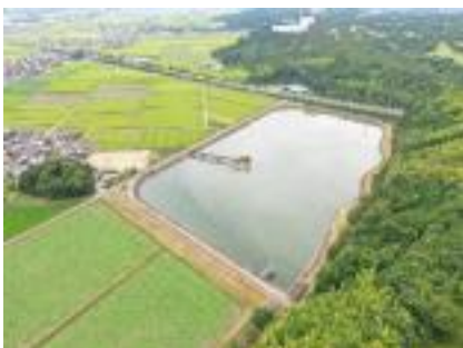
用水施設の整備(調整池)
