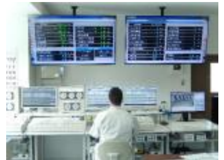
施設の管理(ダム)
