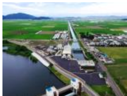
排水施設の整備(排水機場)
