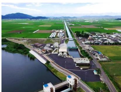
排水施設の整備(排水機場)
