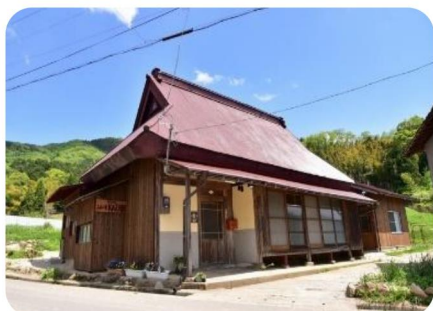
古民家再生(農泊施設)
