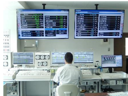
施設の管理(ダム)
