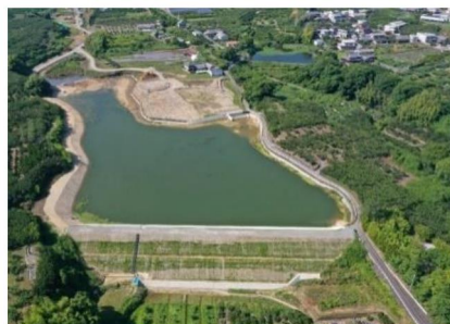
国営総合農地防災事業 和歌山平野地区大溜池(改修後)【和歌山県紀の川市】
