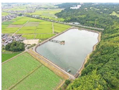
用水施設の整備(調整池)
