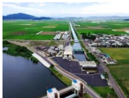
排水施設の整備(排水機場)
