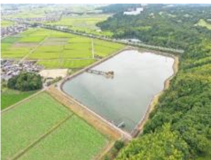
用水施設の整備(調整池)
