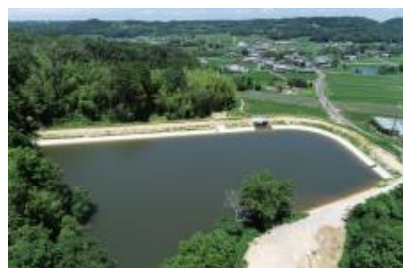
防災対策を施した農業用ため池【兵庫県三木市】
