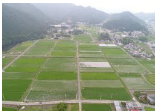
整備後の大区画ほ場(国営亀岡中部地区)
