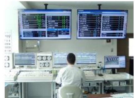
施設の管理(ダム)
