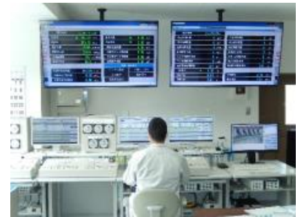
施設の管理(ダム)
