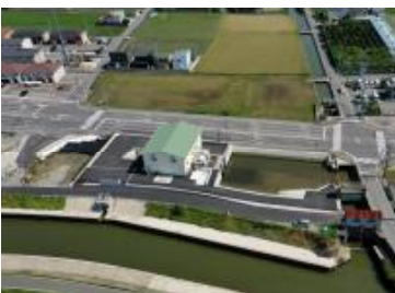
国営総合農地防災事業で整備した排水機場【和歌山県和歌山市】
