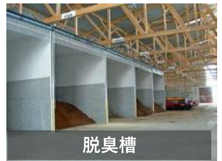
山鹿市バイオマスセンター
